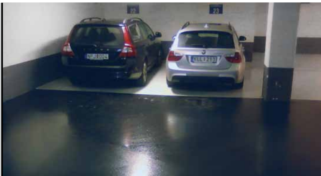
Teatergarasjen i Malmø, Mapefloor PU system.
