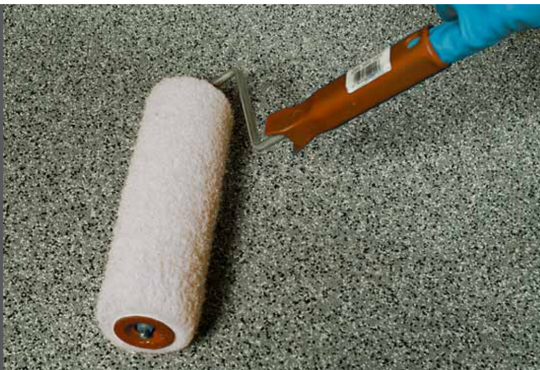
Påføring av topplakk
