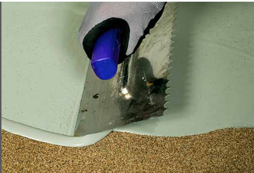
Påføring av rissoverbyggende membran i parkeringshus
